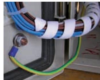
↑ **Figura 1.70.** Separación de los dispositivos de control de los de potencial.
