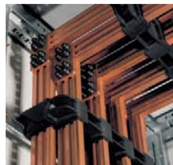
↑ Figura 1.48. Detalle de un embarrado de un cuadro de distribución (ABB).
