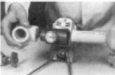
9/ Después de haberse terminado el período de calentamiento, sacamos el accesorio y el tubo de la matriz, y los unimos de forma tal, que con una moderada, lenta y uniforme presión, los introduzcamos, sin rotación del eje, al manguito del accesorio hasta el tope del acoplamiento. Controlamos la unión del eje del tubo con el accesorio.
